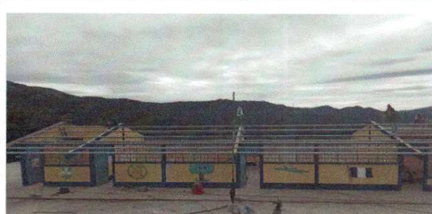
Foto 2: Sustrucion de estructura de soporte de metal por metal
