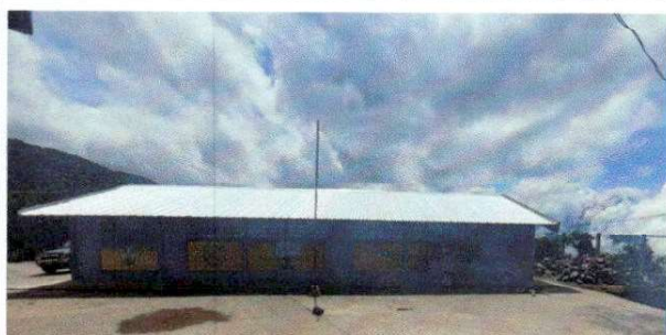
Foto 1: Sustrucion de lamina por lamina troquelada calibre 26
