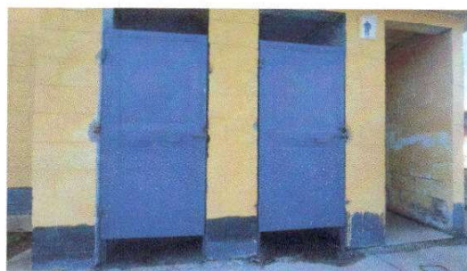
Foto 5: Sustrucion de puertas de baño de madera por puertas de metal
